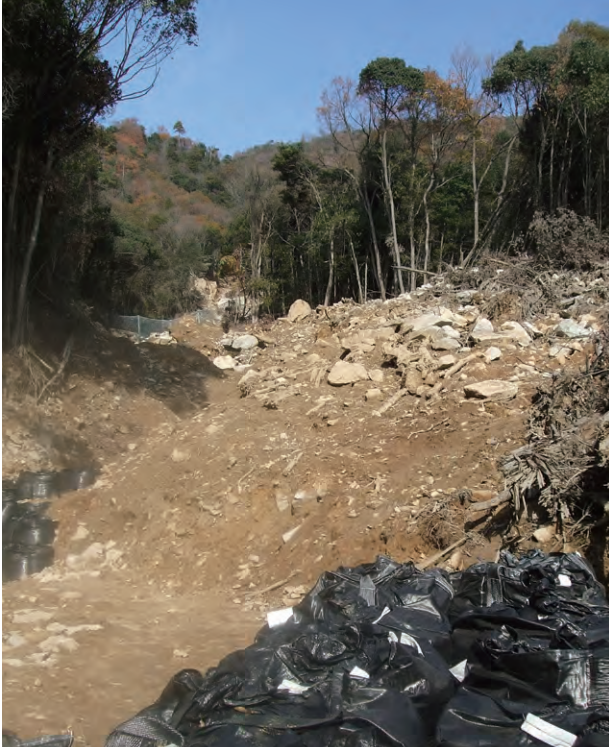
土石流被害のあった広島県安佐南区八木地区の被害現場。
